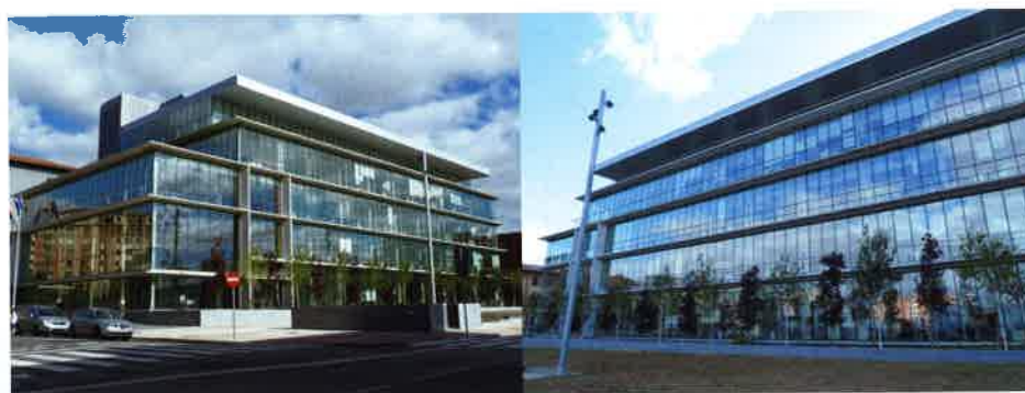
Figura 9: Fachadas del edificio antes de la rehabilitación energética.
