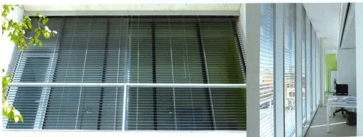
Figura 14: Fachada dinámica con lamas orientables exteriores.
