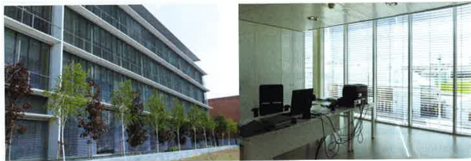
Figura 11: Fachada dinámica con lamas orientables exteriores.
